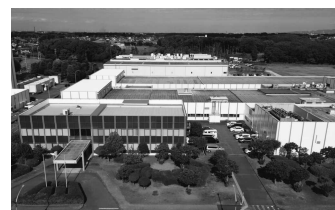
つくば工場 茨城県筑西市
